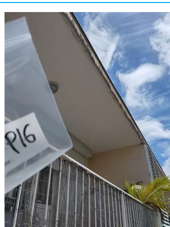
Matériaux : Z10 - Façades - Plafond de balcon - Enduit + peinture Prélèvement : P016 Description : enduit + peinture Localisation : BAT 3 - Façade Avant Droite - Plafond balcon Résultat : Absence d'amiante
