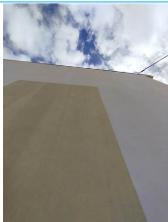
Matériaux : Z01 - Pignons - Mur haut - enduit + peinture Prélèvement : P001 Description : enduit + peinture Localisation : BAT 3 - 1er pignon - Mur haut Résultat : Absence d'amiante
