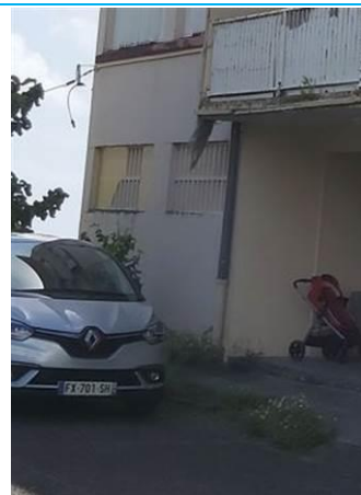
Matériaux : Z08 - Façades - Mur - Enduit + peinture Prélèvement : P022 Description : enduit + peinture Localisation : BAT 3 - Façade Avant Gauche - Mur bas Résultat : Absence d'amiante
