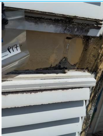
Matériaux : Z09 - Façades - Tranche - Enduit + peinture Prélèvement : P017 Description : enduit + peinture Localisation : BAT 3 - Façade Avant Droite - Tranche horizontale Résultat : Absence d'amiante
