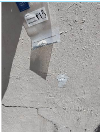
Matériaux : Z08 - Façades - Mur - Enduit + peinture Prélèvement : P013 Description : enduit + peinture Localisation : BAT 3 - Façade Avant Droite - Mur bas Résultat : Absence d'amiante
