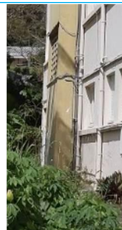
Matériaux : Z13 - Facades - Avancé cage escalier - Enduit + peinture Prélèvement : P032 Description : enduit + peinture Localisation : BAT 3 - Façade Avant Gauche - Avancé cage escalier Résultat : Absence d'amiante
